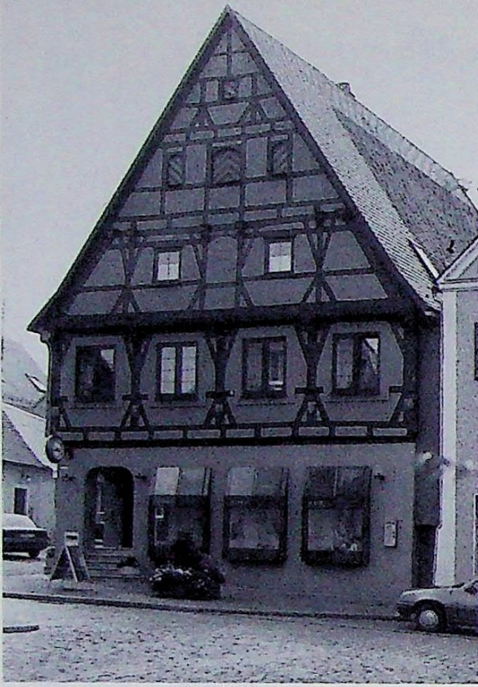
Eine der wenigen freigelegten Fachwerkkonstruktionen: Mangoldstraße 10
